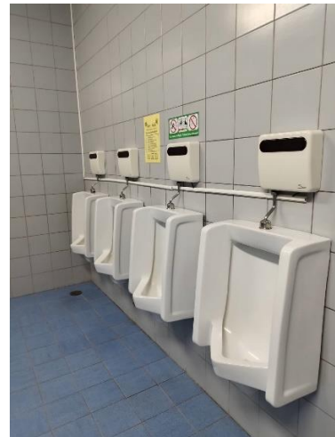
เลือกใช้สุขภัณฑ์ประหยัดน้ำและติดตั้งเซนเซอร์โถปัสสาวะอัตโนมัติ บริเวณโซนห้องน้ำชาย
